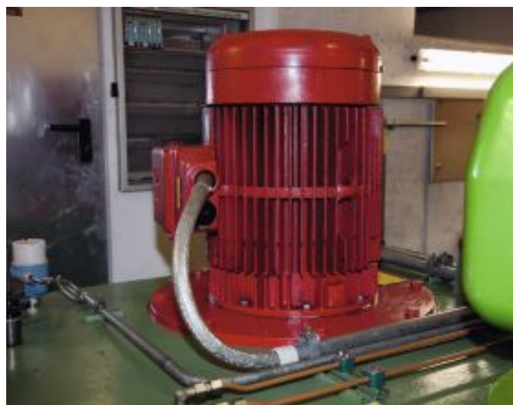
Abb. 3: Falsch dimensionierte Motoren verbrauchen viel Strom.
